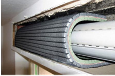
Abbildung 24: Rollladenkastendämmung<sup>19</sup>
